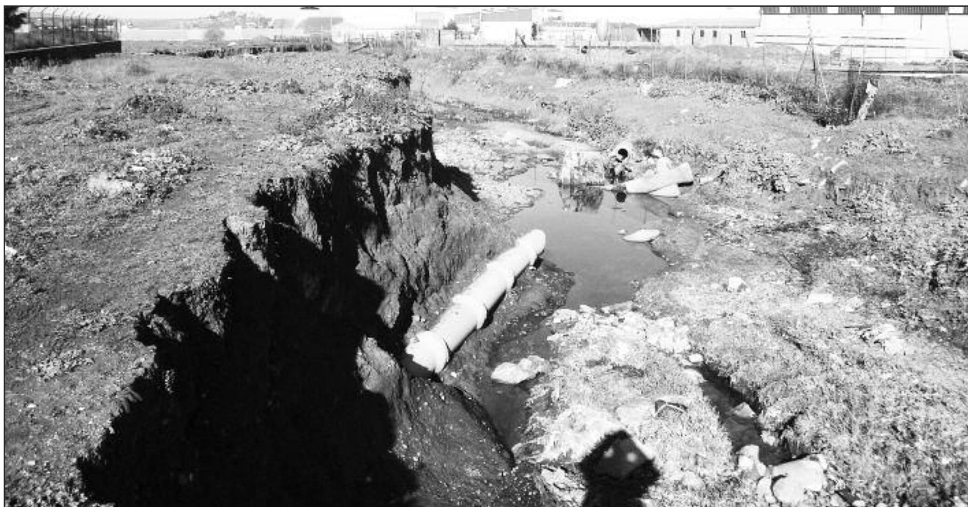
Arroyo Harnina, tramo urbano
