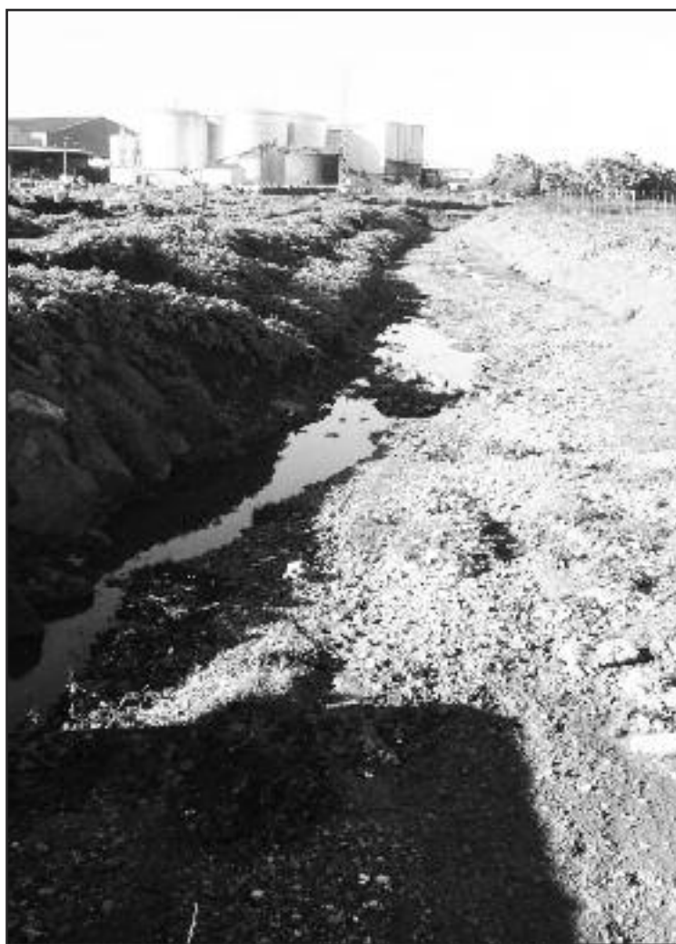
Parte de Las Picadas que está pendiente de mejorar
