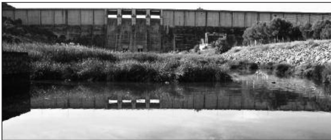
Presa de Alange
