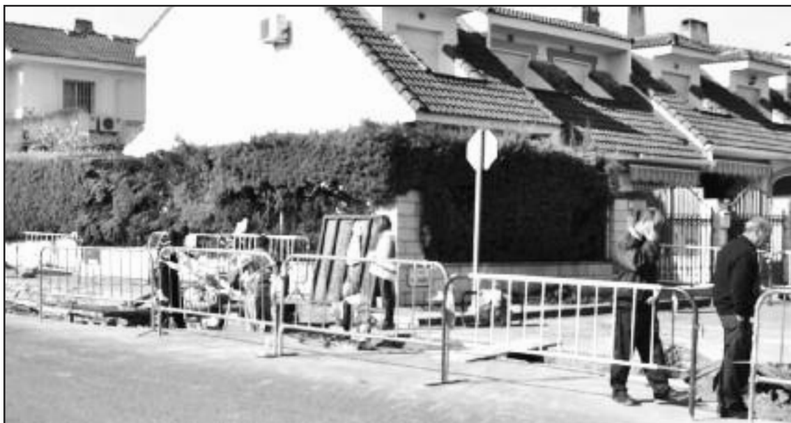
La reforma de los Acerados de la Carretera de la Fuente se hizo con los fondos Aepsa
