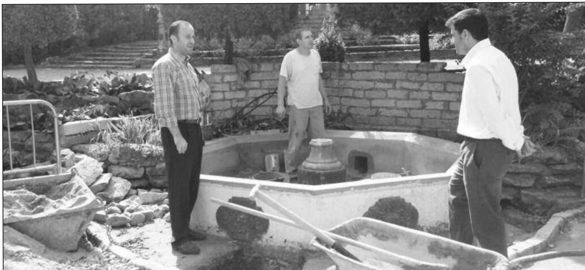
El alcalde y el concejal Díaz de la Peña, de visita a algunas obras de la ciudad. Reforma de una de las fuentes del parque de la Piedad
