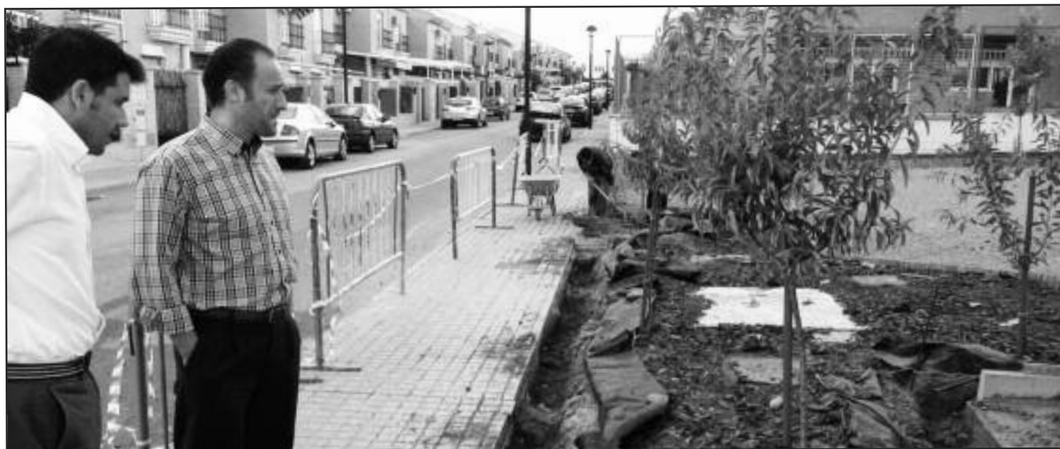
Obras en el parque del Recuerdo
