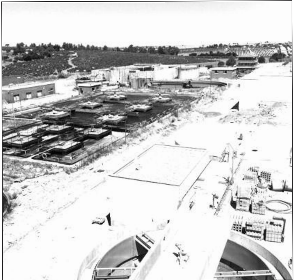
Foto de archivo de 2011, en plena construcción de la primera fase de la nueva depuradora
