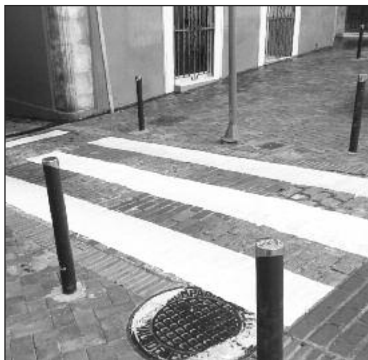
Se está procediendo también al repintado de la señalización horizontal
