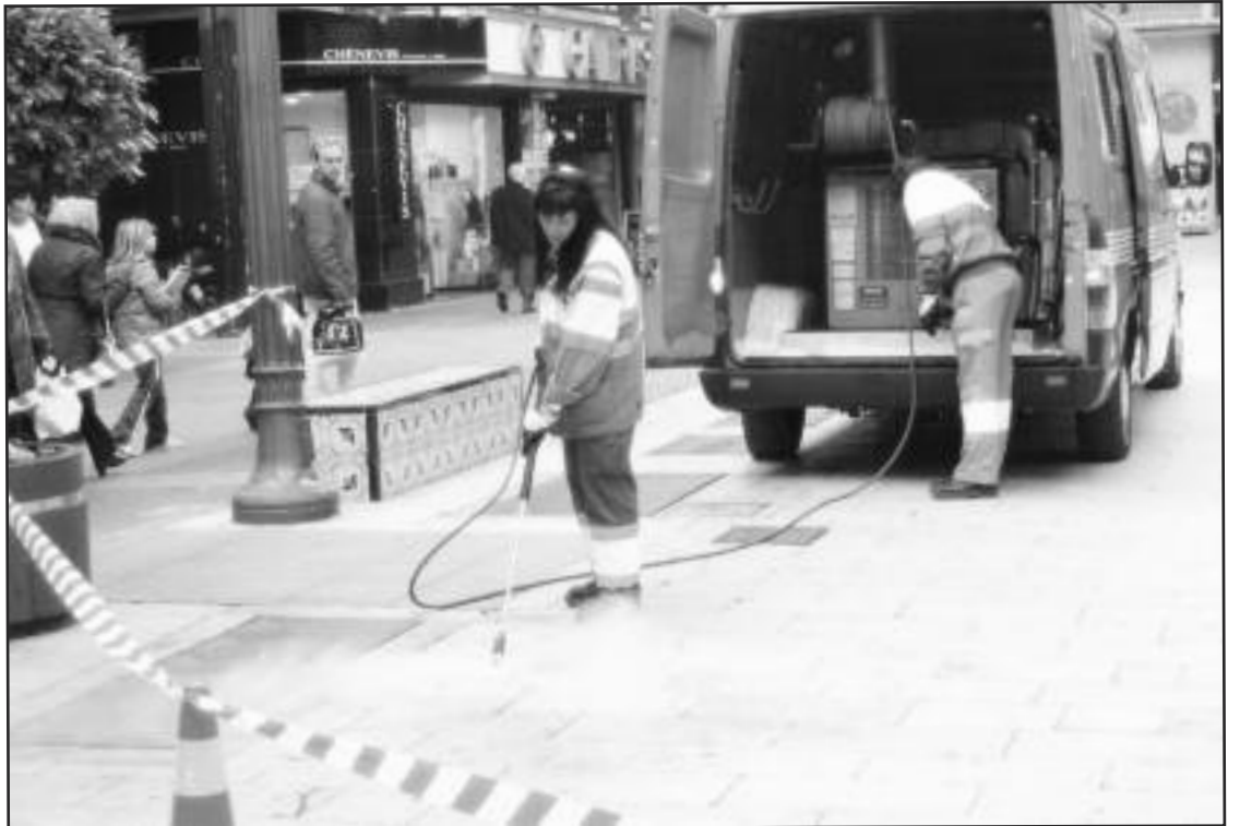
Sistema de baldeo de alta presión
