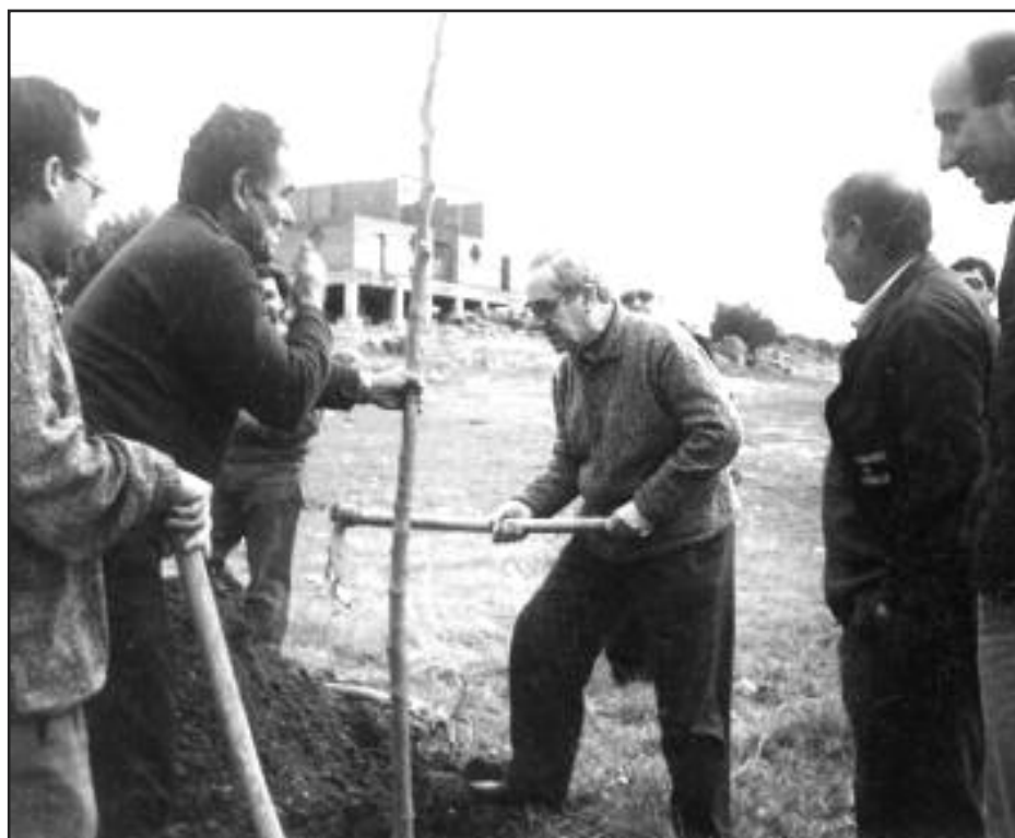
Don Jesús plantando un árbol en San Marcos. Ermita en construcción
