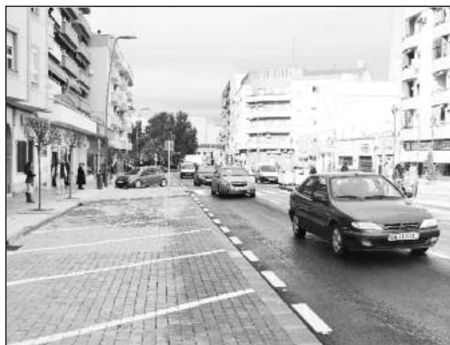
En diciembre de 2012, se abrió al tráfico la nueva Avenida de la Paz
