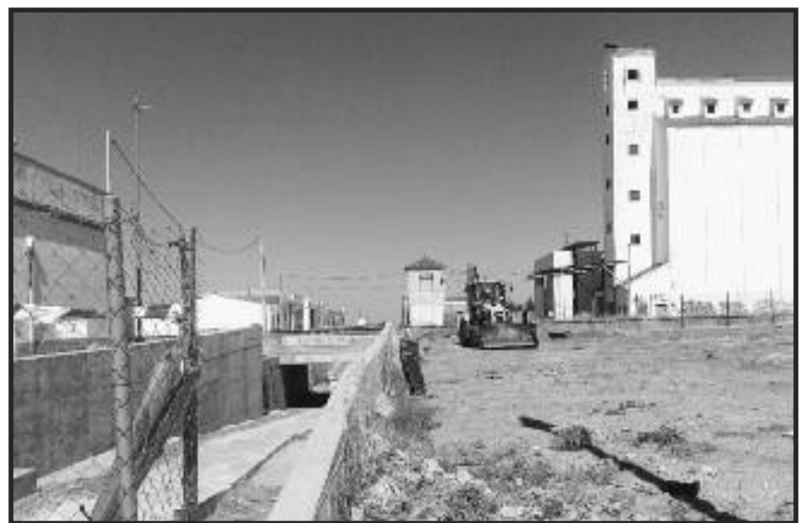
Paso a nivel del camino Alange
