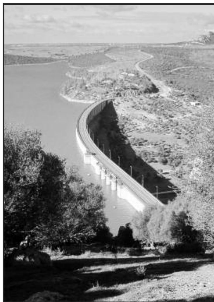
Presa de Alange
