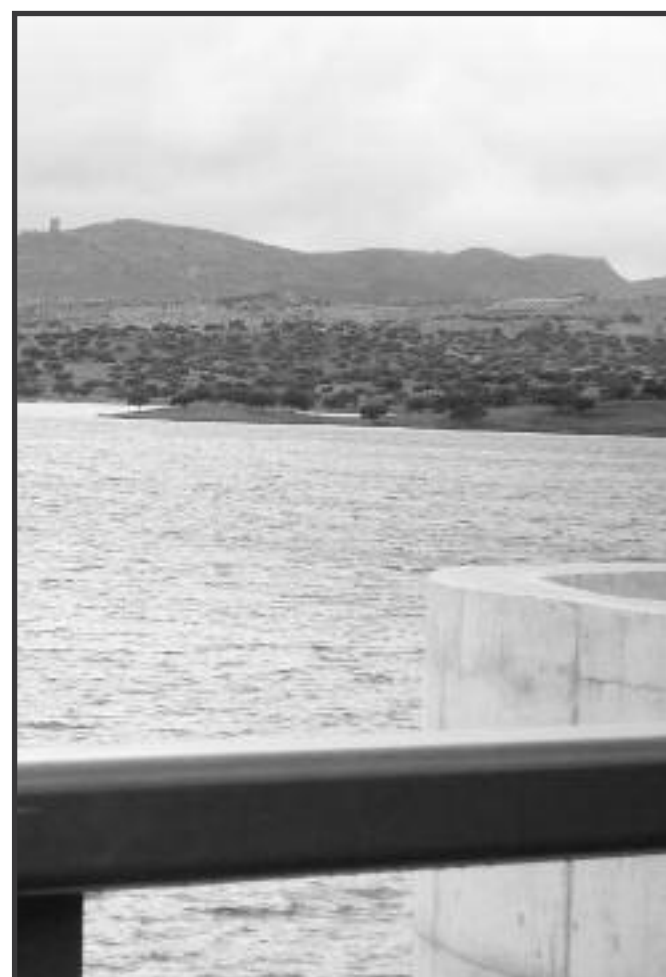
Presa de Villalba.
