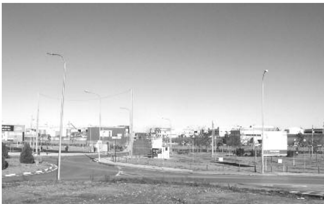
El ayuntamiento ya ha hecho frente al pago de indemnizaciones por las expropiaciones de terrenos.
