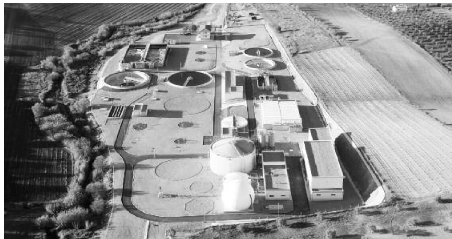
La nueva estación depuradora de aguas residuales se puso en marcha en el primer trimestre de 2014. Esto ha supuesto unos sobrecostes para Socamex.
