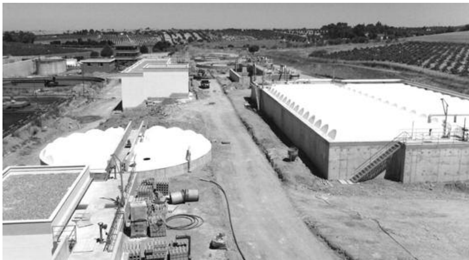
La nueva EDAR entró en funcionamiento en el primer trimestre de 2014; la obra, que duró seis años, contó con un presupuesto de 17 millones de euros.
