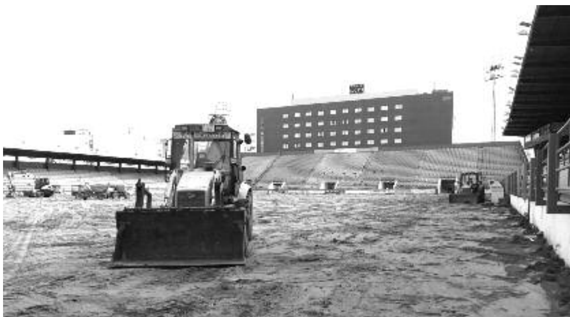
Obras de cambio de césped llevadas a cabo hace unas semanas.
