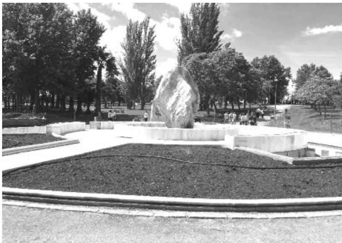
Obra de la fuente central del parque de las Mercedes, que se está haciendo con fondos AEPSA.
