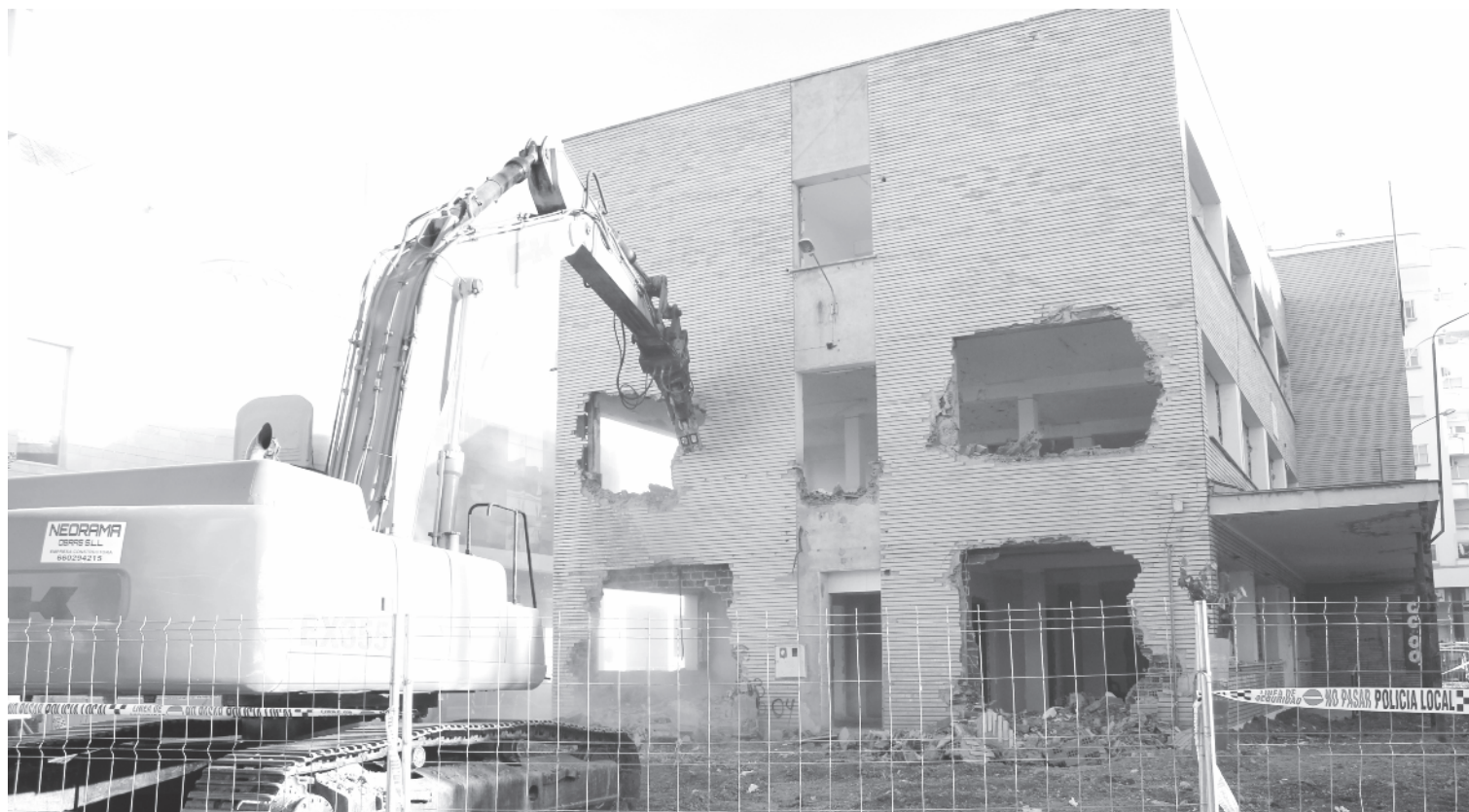
El día 25, comenzó el derribo.
