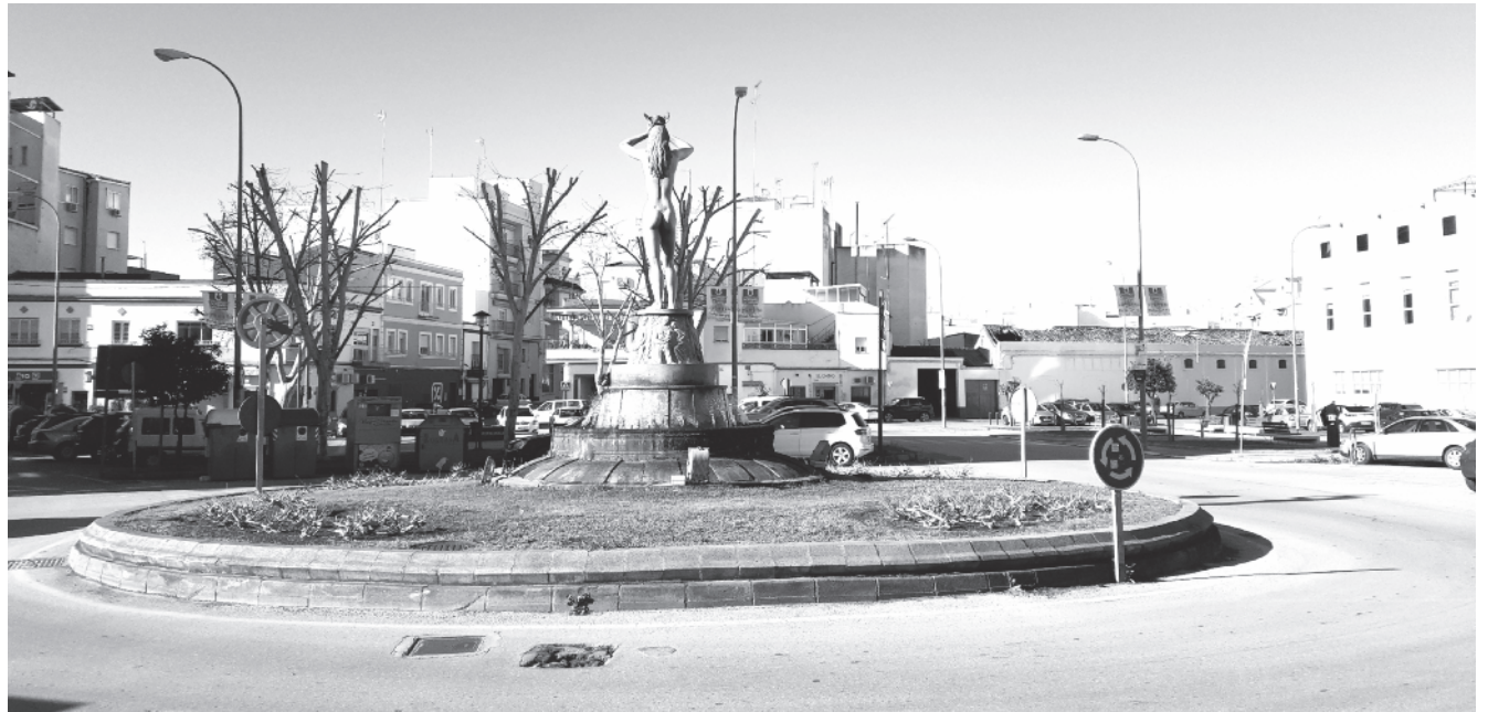
La reforma de la Plaza de Extremadura será la primera obra que se hará con los EDUSI.
