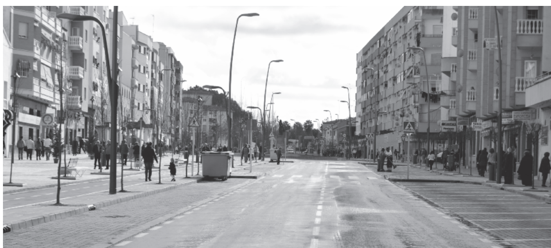
La obra de la avenida de la Paz se hizo con los primeros FEDER que llegaron; la actuación finalizó en diciembre de 2012.
