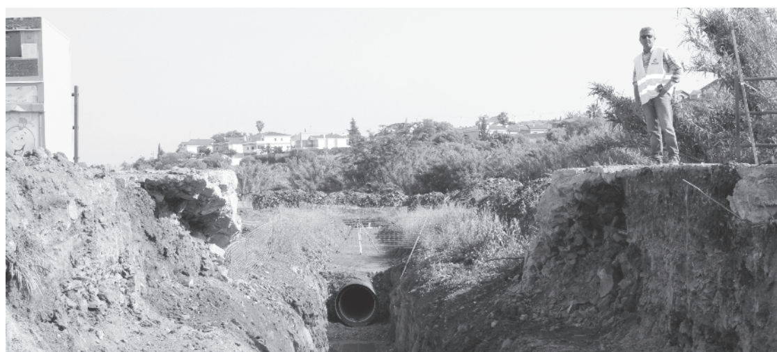
Obra del emisario de aguas residuales.
