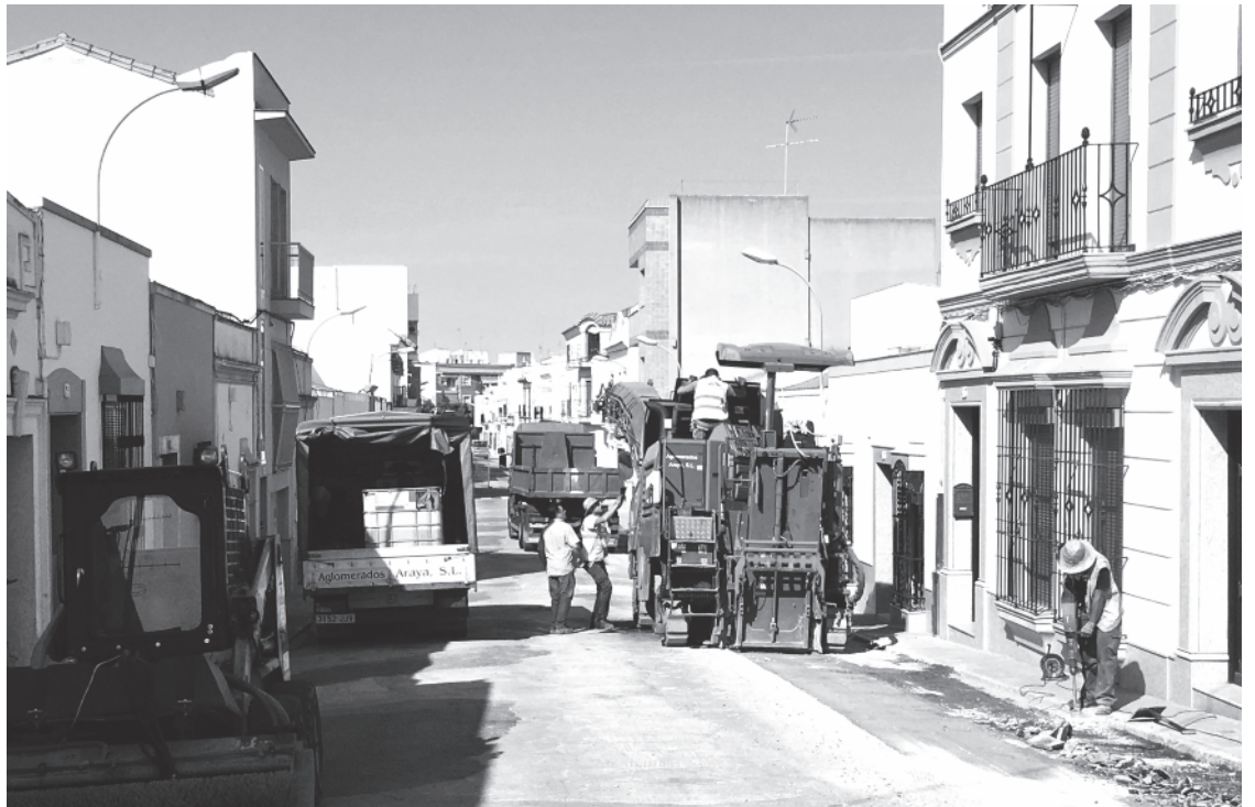
En la calle Piedad se ha sustituido la red de saneamiento y se ha asfaltado.
