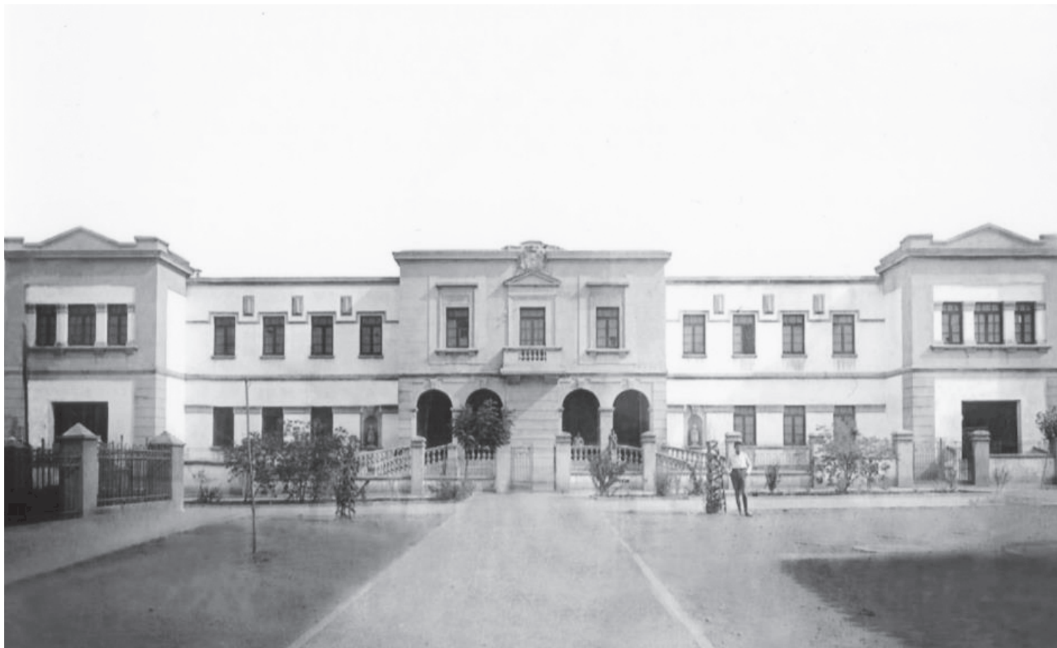
Aspecto de la fachada del edificio que ha albergado durante 90 años el colegio, hoy con el nombre de Antonio Machado.
