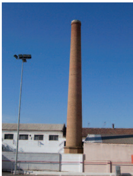
Imagen de la chimenea antes.
