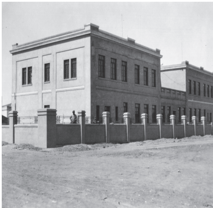
Obras de construcción, en el año 1929.
