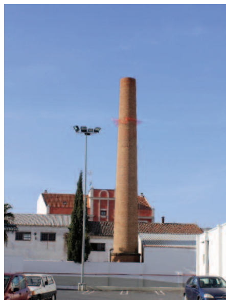
Imagen tras el derribo.
