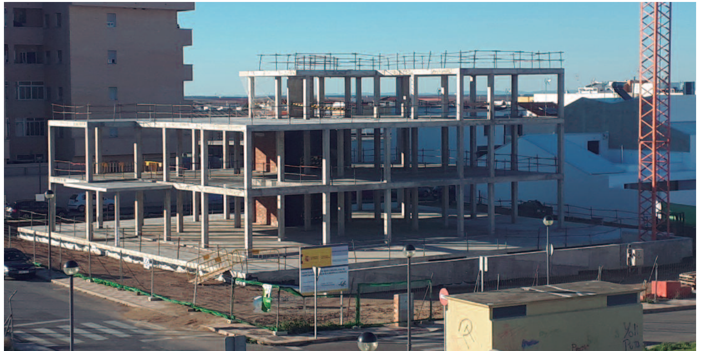
Estado en el que ha quedado la obra de la comisaría tras paralizarse.
