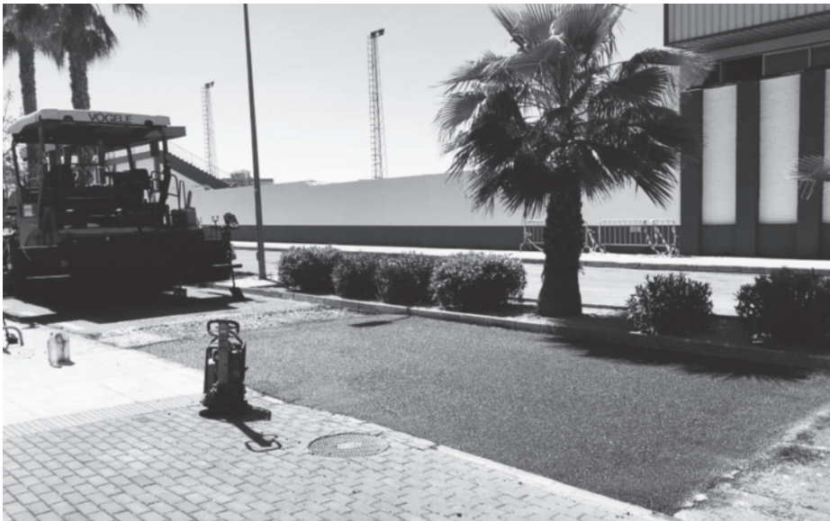
Máquina de asfaltado en la calle Nicolás Megía, junto al polideportivo municipal.
