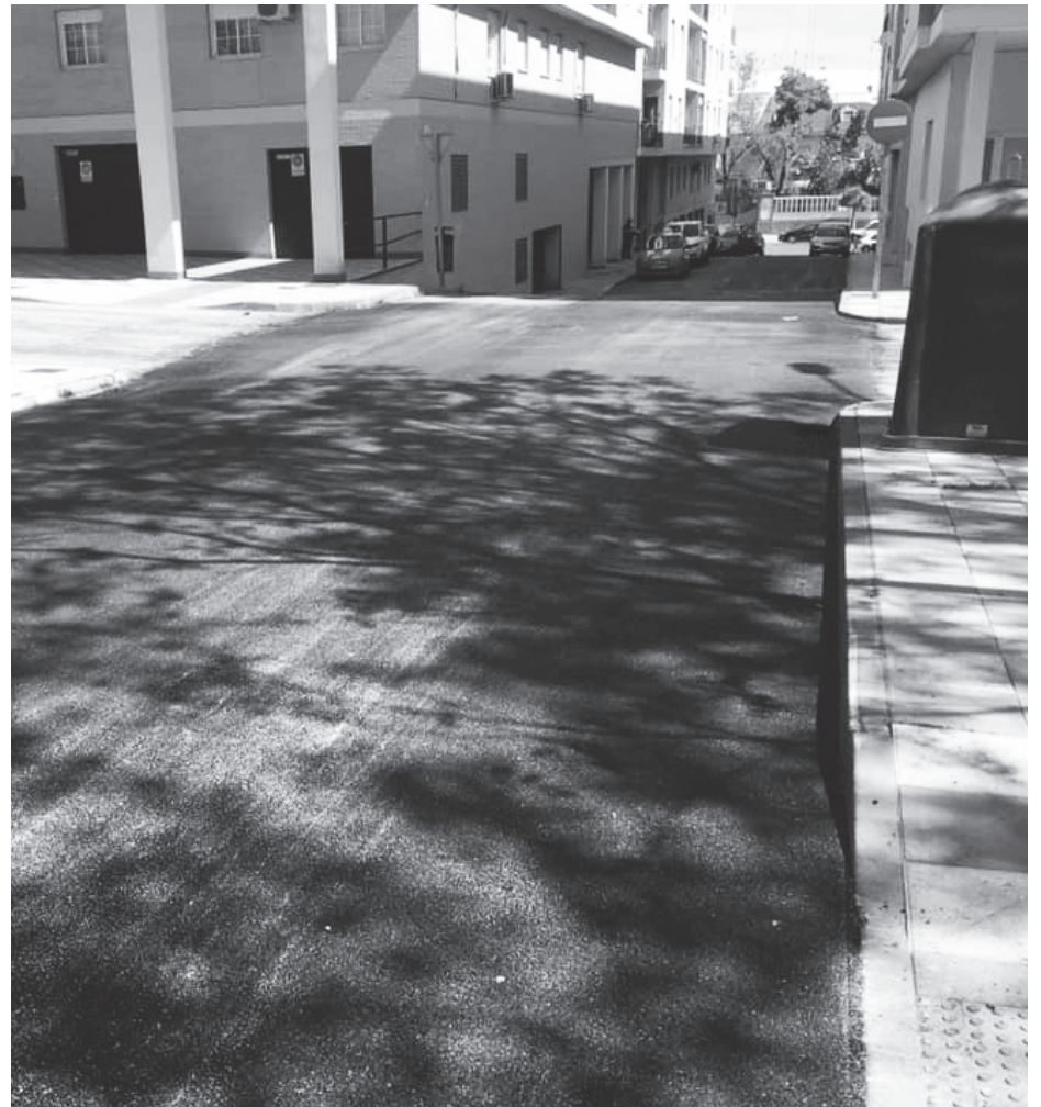
Tramo de la calle Miguel de Unamuno ya asfaltado.
