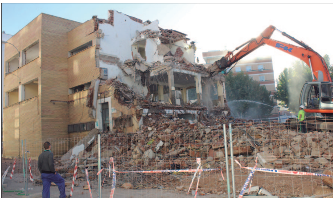
Trabajos de derribo del edificio del sindicato tras años de litigios con los ministerios.
