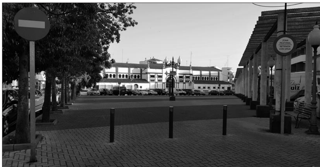
Bolardos instalados para que no accedan los coches a la explanada de la plaza del Mercado.
