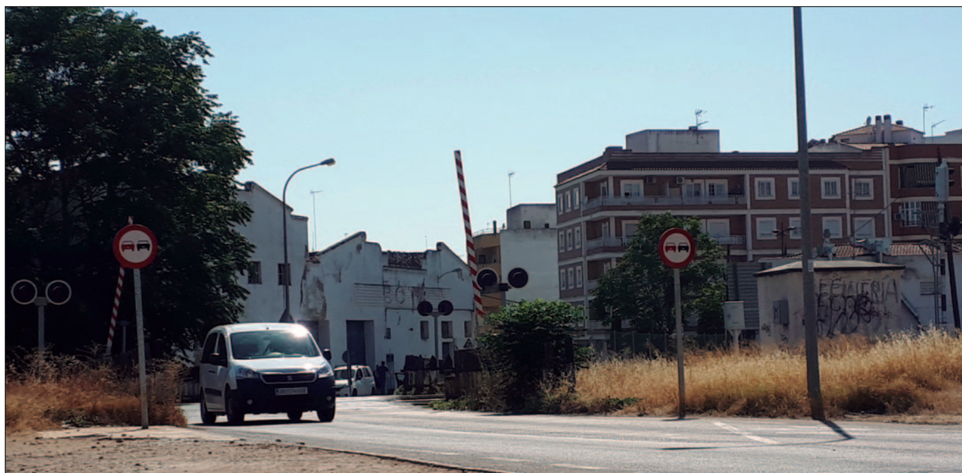
Paso a nivel de la carretera de Alange, el cual se pretende retomar el proyecto para su eliminación.
