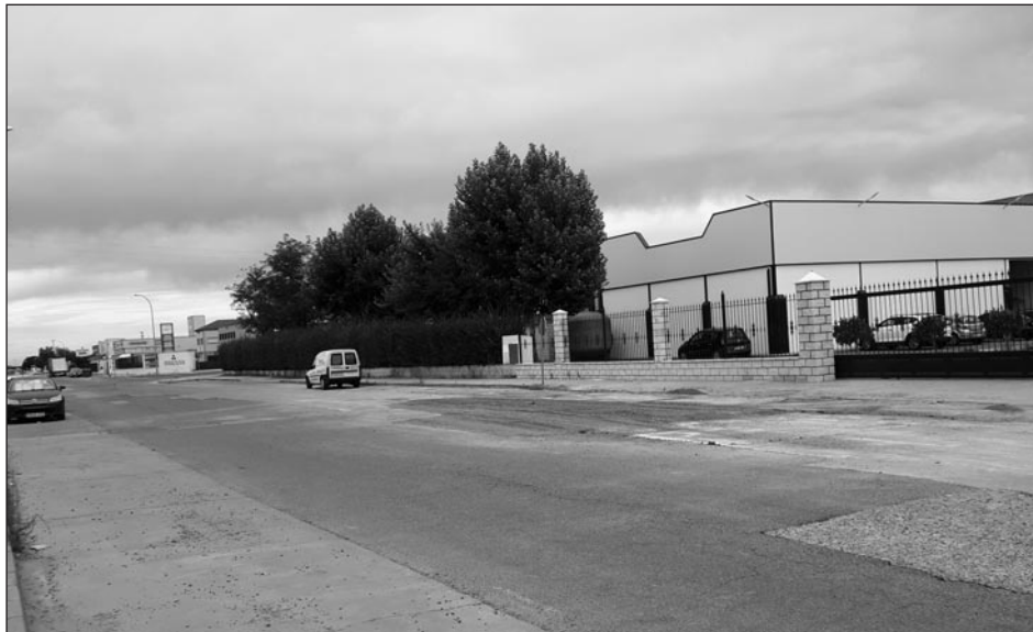
Una de las calles del polígono donde se producen más roturas de tuberías.
