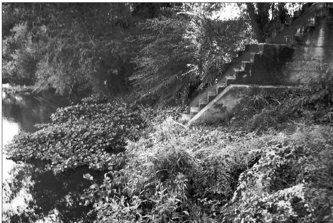
Toma de agua del río Guadiana, de la que se abastece Almendralejo. FOTO: PLATAFORMA CONTRA LA CONTAMINACIÓN
