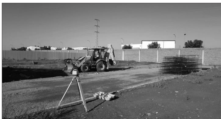
Obras de construcción de los 108 nichos en el cementerio municipal.
