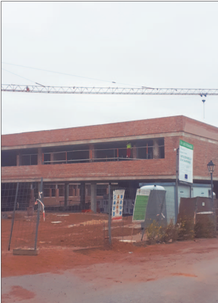
Obras de construcción del nuevo colegio en la zona de San Roque.
