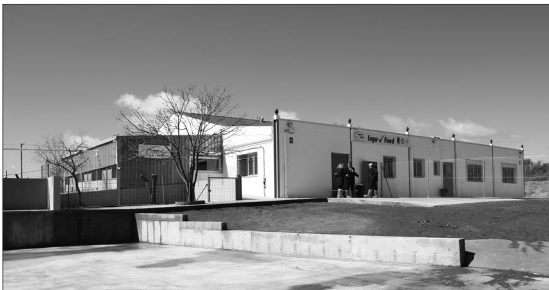
Instalaciones de la granja de porcino de Inga Food, ubicada en Almendralejo.
