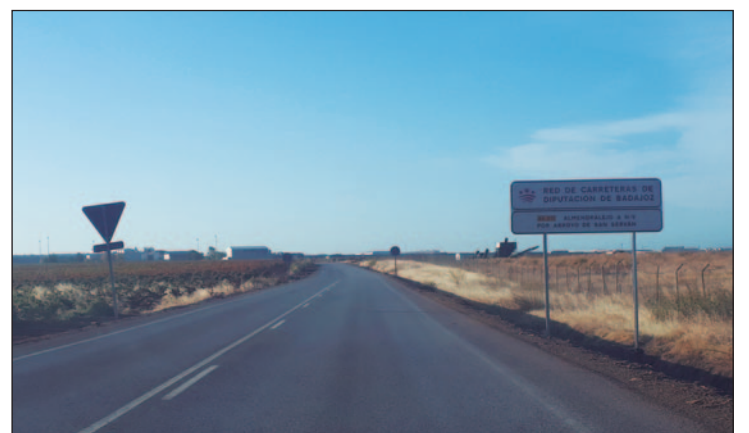
Carretera que une Almendralejo con Arroyo de San Serván.
