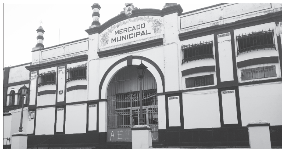
Edificio del antiguo mercado de abasto que tendrá un uso mixto.
