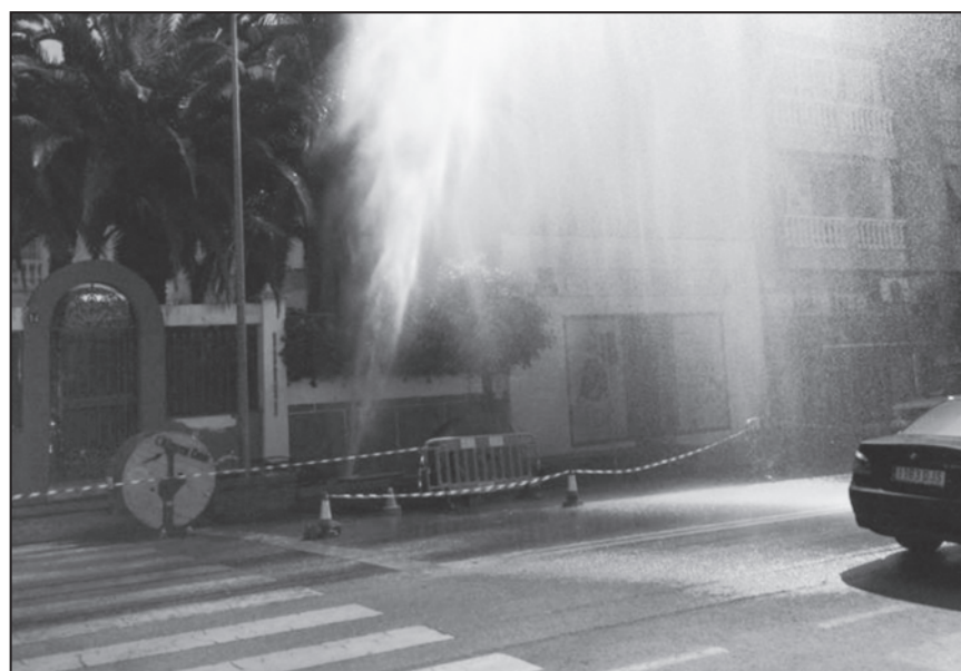
Rotura de una tubería de agua en la calle López de Ayala.
