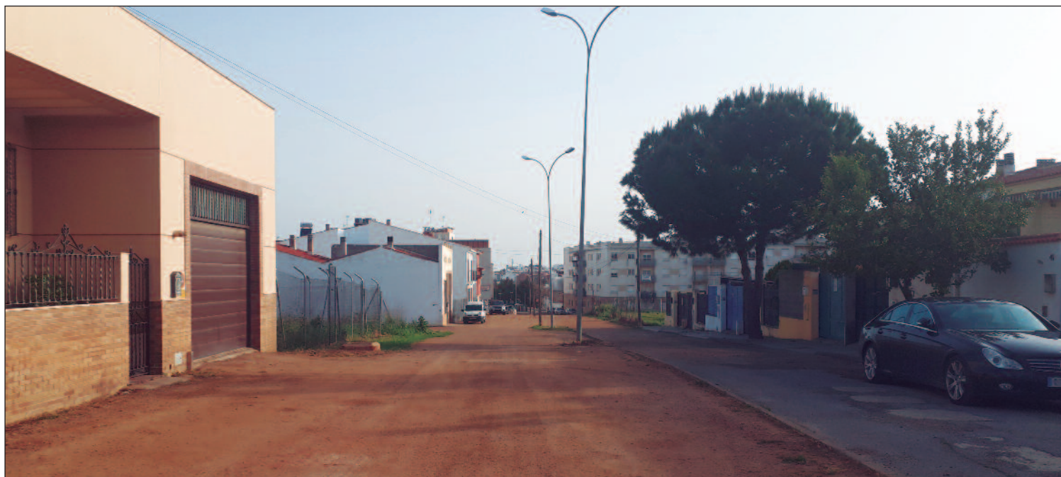
Calle Navalmoral de la Marta, cuya urbanización contará con una partida en los próximos presupuestos municipales.
