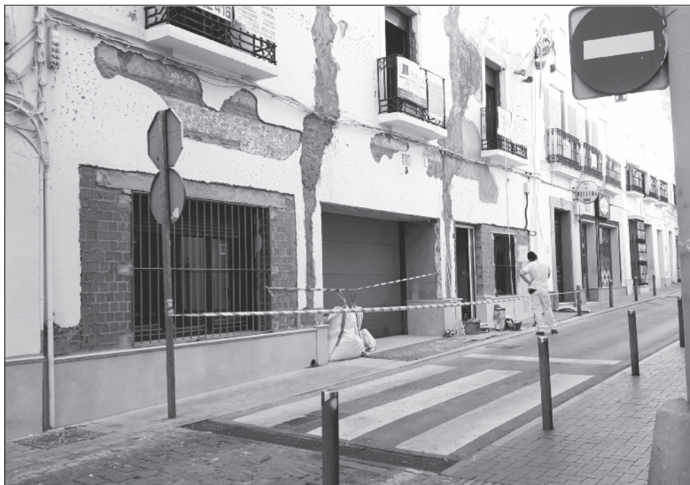
Arreglo de la fachada de una vivienda, tras realizar obras.
