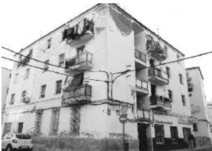
Pisos conocidos como San Enrique, cuya fachada se arreglará.
