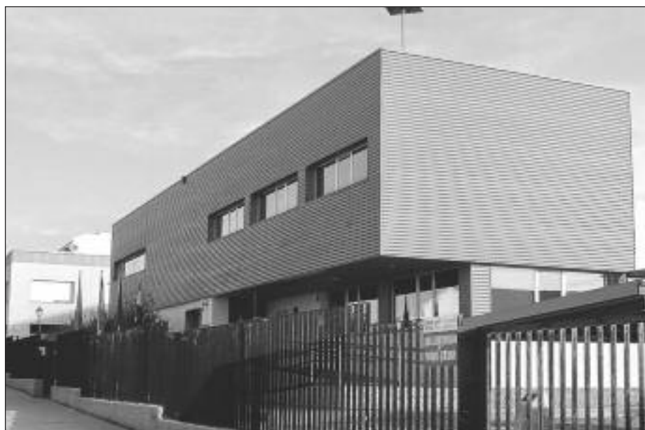
Instalaciones que acogen las oficinas del Sexpe en Almendralejo.
