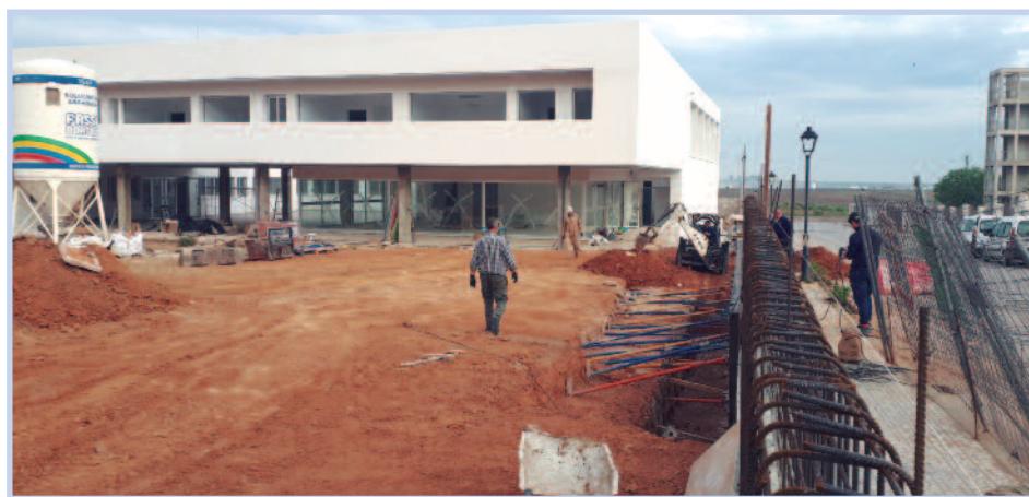
Obras de construcción del colegio en la calle Puebla de la Reina.
